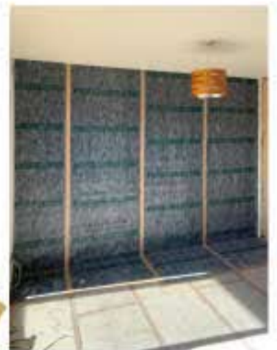
↑下地施工(遮音シートなど)
